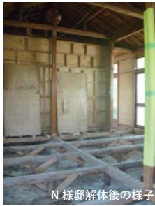
N様邸解体後の様子
