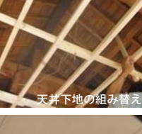
天井下地の組み替え
