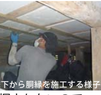
床下から胴縁を施工する様子
